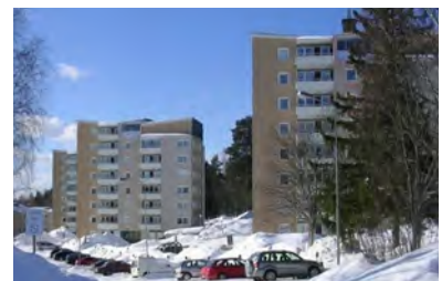
Umias energibesparingsprojekt tillsammans med BRF Snödroppen i Skellefteå går till och med bättre än kalkylen. Besparingen blir mer än 400 MWh per år.
