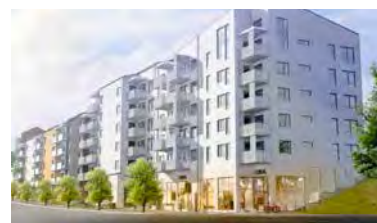
Totalinstallation, kv Vaktstugan, Ursvik. Uppdragsgivare: Wählin Byggare AB.
