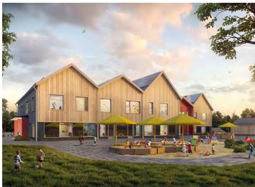
Totalinstallation, Brage förskola, Märsta. Uppdragsgivare: COBAB Sverige AB.
