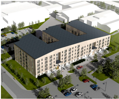
Förbättrade tekniska lösningar reducerade utsläppen vid bygget av Polstjärnan.
